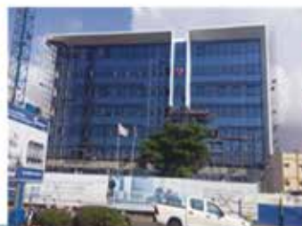
Travaux de bâtiments
