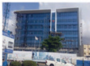
Travaux de bâtiments
