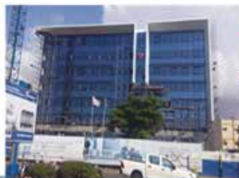
Travaux de bâtiments
